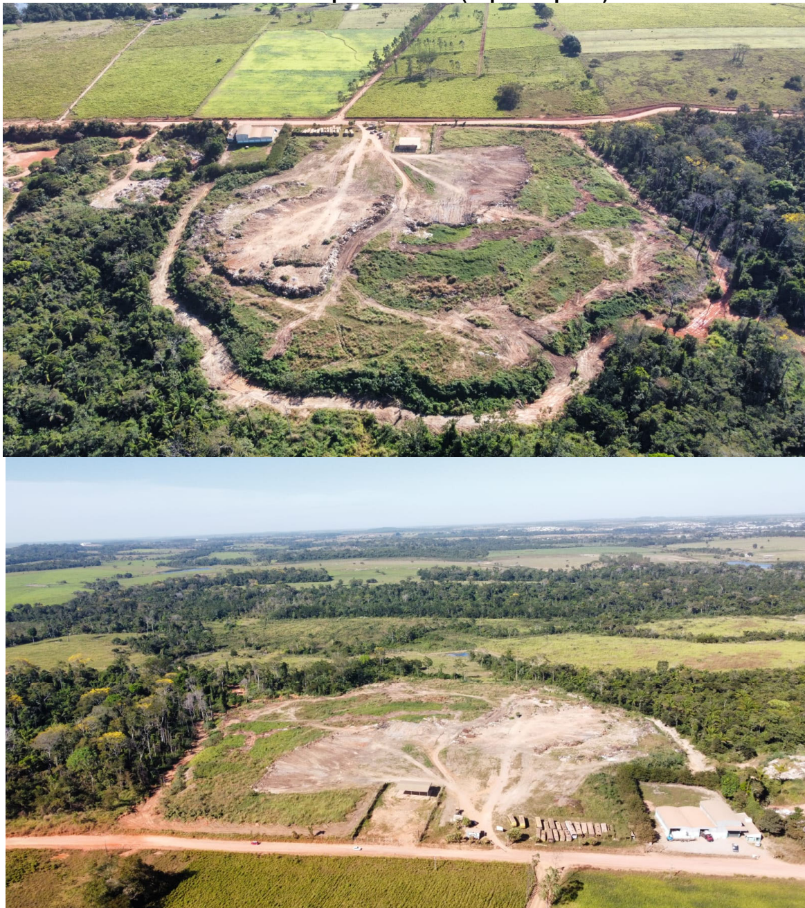
Figura 15. Registro fotográfico Área Passivo 02: Área de deposição de RCC, Volumosos e Resíduos da Limpeza Pública (capina e poda) – Junho de 2025.
