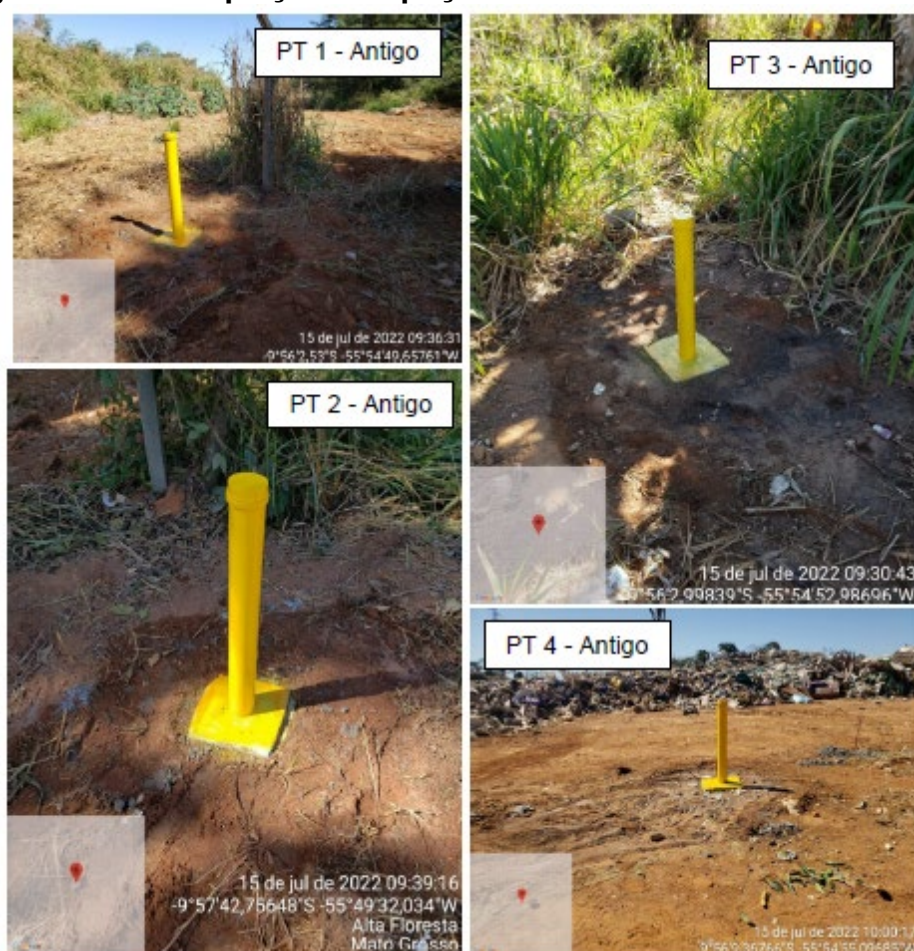
Figura 25. Readequação dos poços de monitoramentos existentes.
